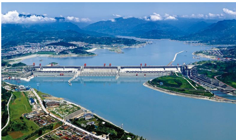
Slika 10. – Three Gorges Dam/ Brana Tri klanca- najveća hidroelektrana na svetu (Izvor: Vassar College's WordPress, Vassar College Community)
