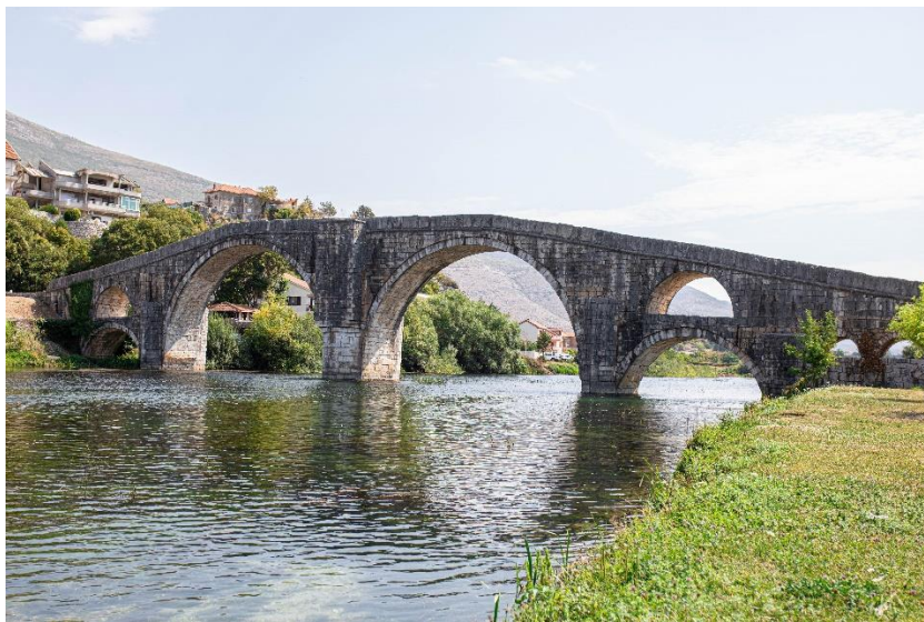
Слика 9. – Перовића мост (фото: Грубач А, 2022)
