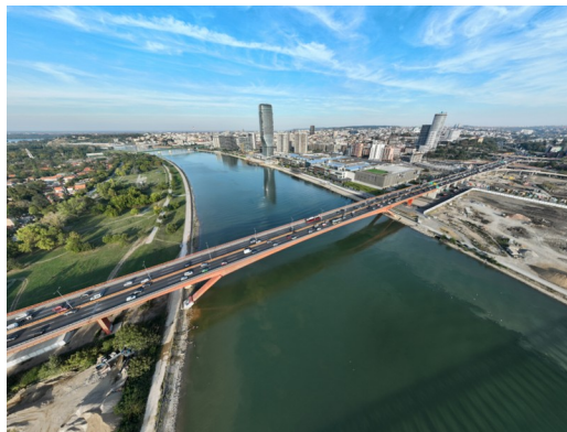
Мост Газела, Сава
